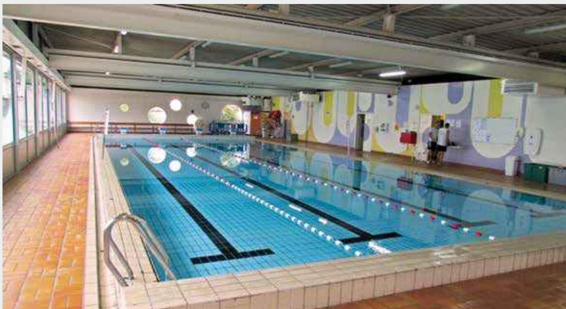
La construction d'un centre aquatique à Vitry-le-François doit permettre de remplacer l'ancienne piscine municipale.
